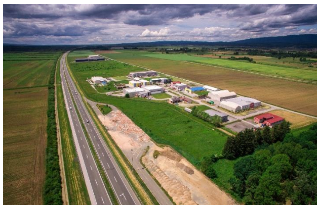
Slika 6.: Industrijski park Nova Gradiška
