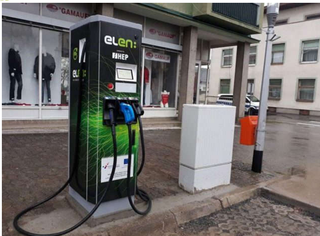
Slika 9. Punionica električnih vozila
