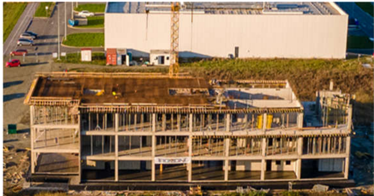
Slika 20: Izgradnja Centra kompetencija za napredno inženjerstvo Nova Gradiška (Izvor: CEKOM NG)
